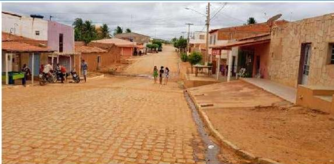
Foto 02: Rua do Distrito de Socorro sem coleta Esgoto
